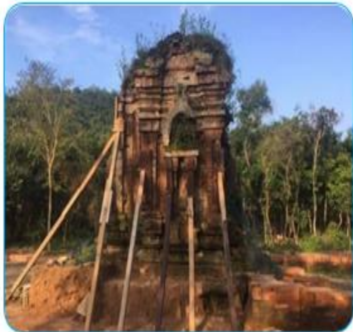
Hình 3.3. Tháp Chăm (nhóm tháp K, Mỹ Sơn) đang được chống đỡ để trùng tu, phục hồi
