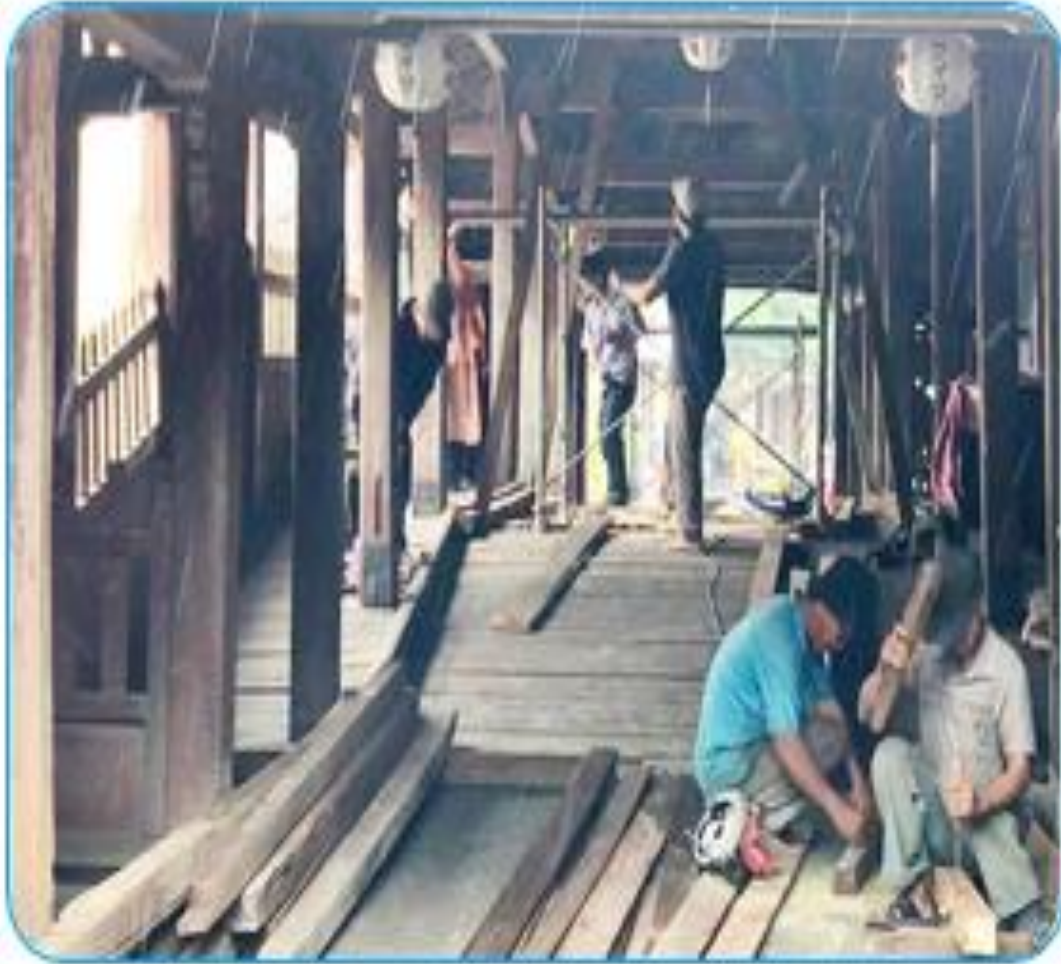
Hình 3.1. Chùa Cầu (Hội An) đang được chống đỡ
