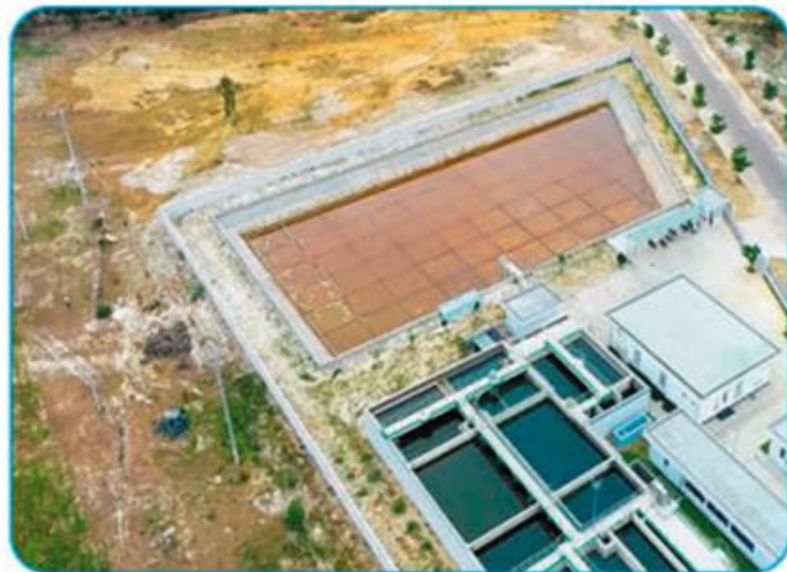
Hình 6.8. Trạm xử lý nước thải khu công nghiệp Tam Thăng 2, thành phố Tam Kỳ
