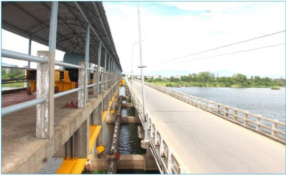
Hình 6.6. Đập Bara ngăn mặn ở xã Duy Thành
