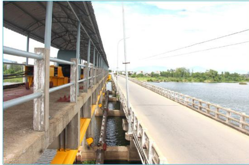
Hình 6.6. Đập Bara ngăn mặn ở xã Duy Thành
