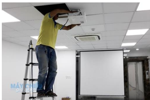
Lắp đặt thiết bị điện tử
