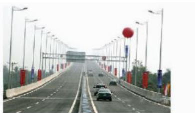
Hình 7.31. Các cây cột đèn có phương thẳng đứng nên không vuông góc với mặt dốc.
