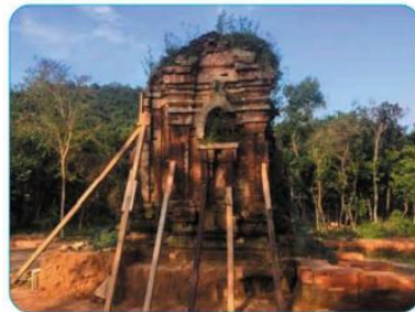
Hình 3.3. Tháp Chăm (nhóm tháp K, Mỹ Sơn) đang được chống đỡ để trùng tu, phục hồi
