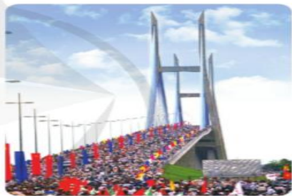
Hình 1. Cầu Mỹ Thuận trong ngày khánh thành (21-5-2000)
