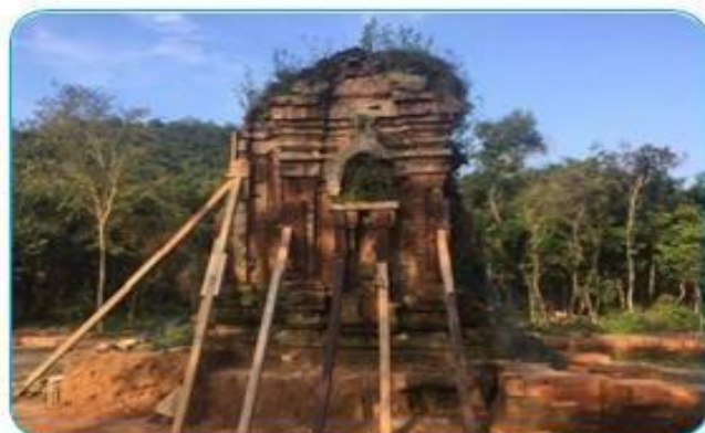
Hình 3.3. Tháp Chăm (nhóm tháp K, Mỹ Sơn) đang được chống đỡ để trùng tu, phục hồi
