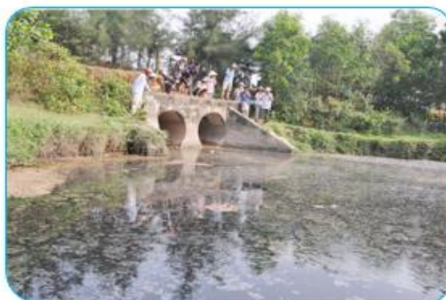
Hình 6.7. Khu vực đầu nguồn của mương Cầu đầu nổi với cống xả nước thải của khu công nghiệp Bắc Chu Lai
