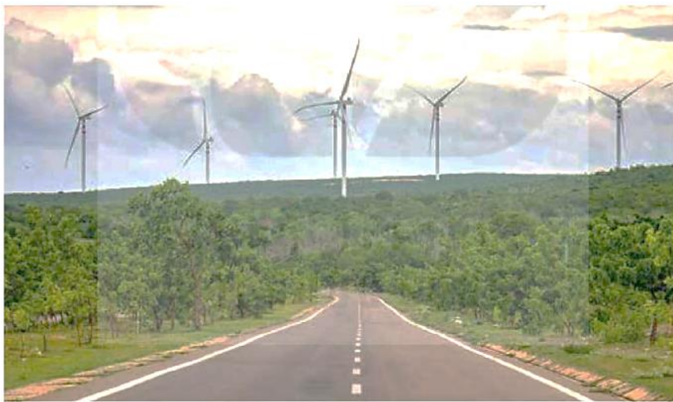
Hình 34.3. Một số turbine gió của nhà máy điện Tuy Phong tỉnh Bình Thuận
