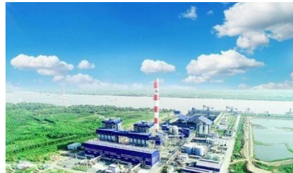
Nhà máy nhiệt điện Sông Hậu
