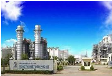
Nhà máy nhiệt điện Phú Mỹ
